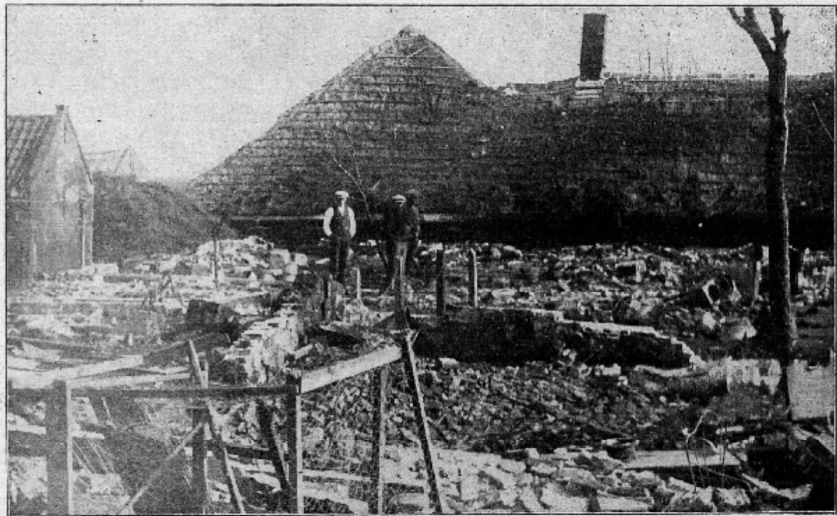
Zaterdag 30 dezer heeft te Koedijk een zware brand gewoed. Een complex, bewoond door de gezinnen G. Meijer, C. Goed, P. Schekkerman, manufacturier, en M. Stam, is tot den grond toe afgebrand. De oorzaak van den brand is onbekend; het geheel was verzekerd. Hierboven een kijkje op de ruïne.
