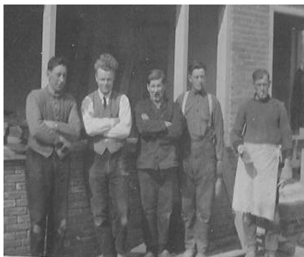
Werklieden van de firma Visser en Krum tijdens de bouw. Op de foto links Leen Visser en Teun Visser.
