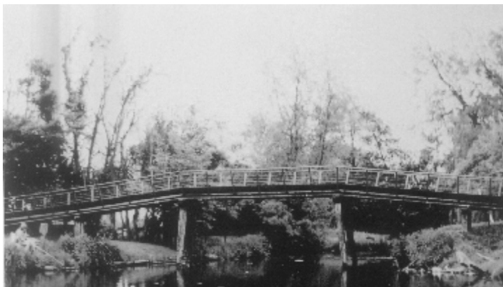
De brug over de Veert van na 1930. Deze brug deed dienst tot aan de ruilverkaveling van de jaren '70.
