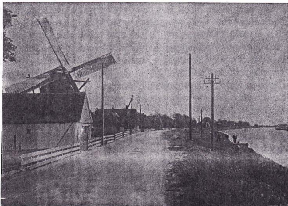
Bovenstaande foto laat zien dat er twee soorten kabels via palen bovengronds liepen. De opname is genomen in 1927 bij de molen van maalderij Bos. De palen links zijn voor de stroom en de palen rechts in de dijk zijn voor de telefoon.
