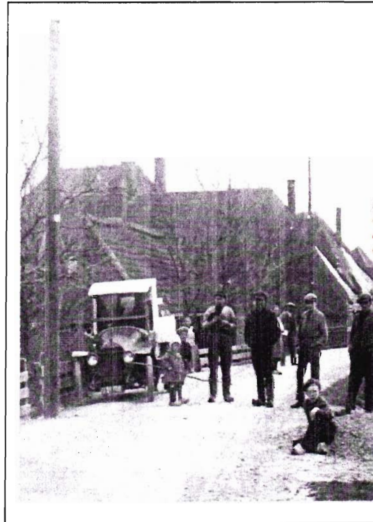
Rechts in de dijk ziet u de hopen grove steenslag. De man links staat op het paardenpad...
